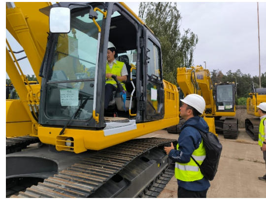
建設機械の確認
